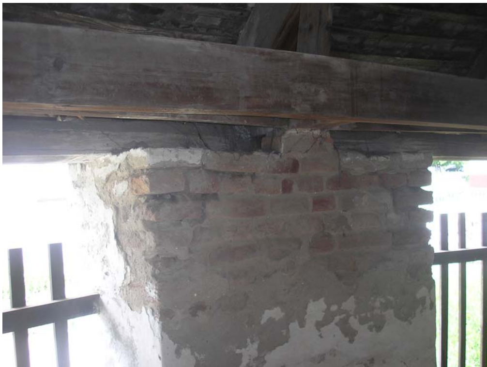
Стање фасадног стуба који носи конструкцију вретена мај 2015. године
