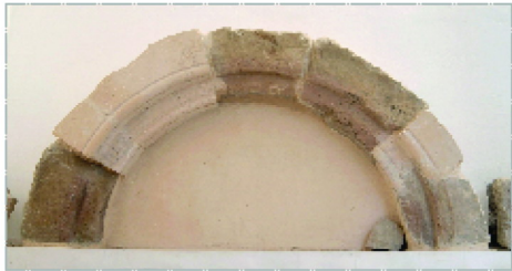
РЕКОНСТРУКЦИЈА АРХИВОЛТЕ ПОРТАЛА ТРПЕЗАРИЈЕ
