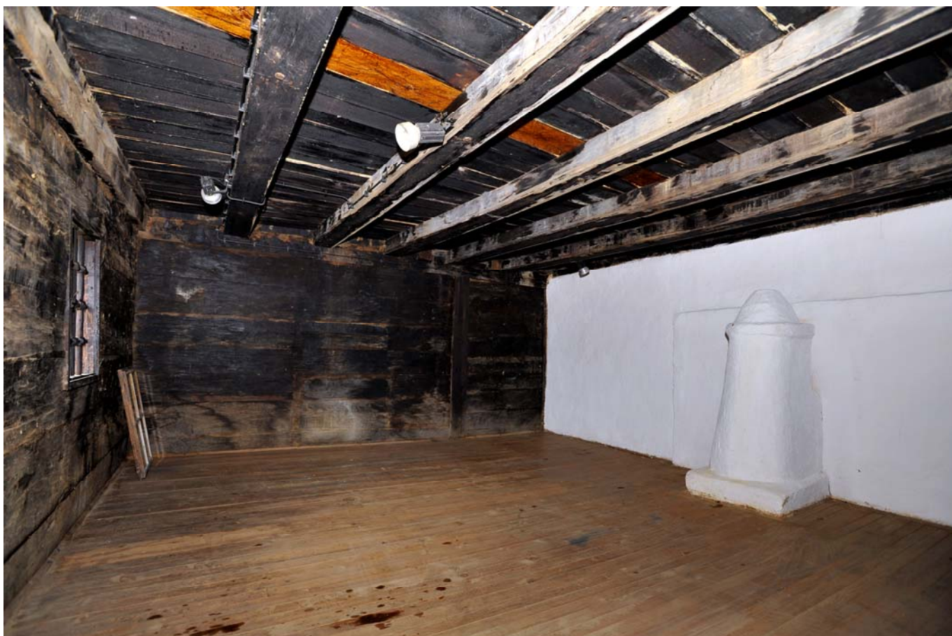
Соба у конаку, предвиђено је унутрашње заштитно премазивање и постављање новог шашовца
