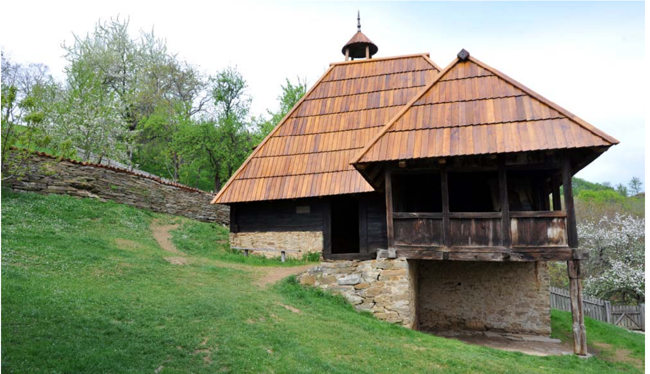
Западна фасада. Потпорни зид у првом плану је предвиђен за презиђивање.
