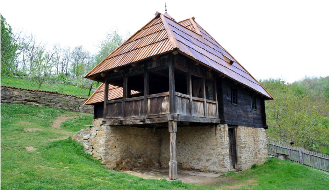
Западна фасада. Потпорни зид у првом плану је предвиђен за презиђивање.
