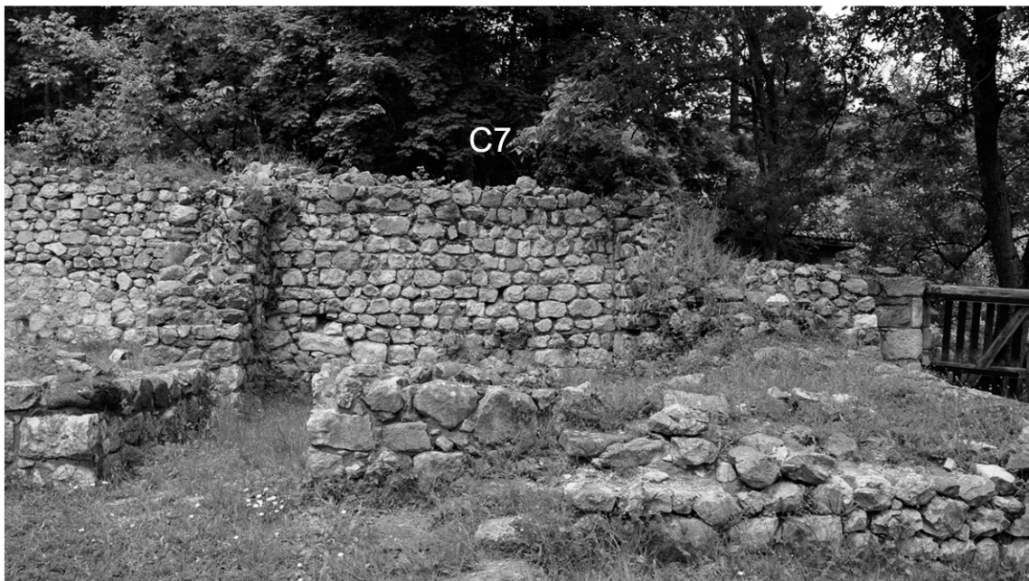
ПРОСТОРИЈЕ C5, C6, C7 СЕВЕРНЕ ГРАЂЕВИНЕ
