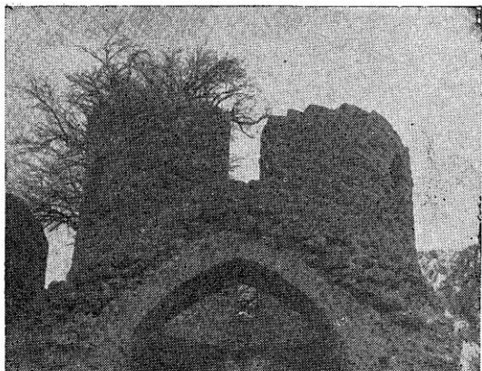
Сл. 12. Централно кубе после конзервације, поглед са запада. — Fig. 12. La coupole centrale, vue du côté de l'ouest après la conservation.
