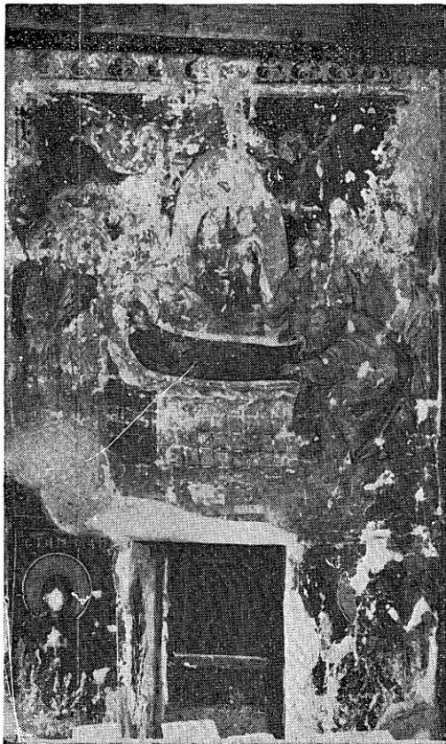
Сл. 2. Западни зид после радова на чишћењу фресака и попуњавању оштећења. — Fig. 2. Le mur ouest après le nettoyage des fresques et le plissage des endommagements.
