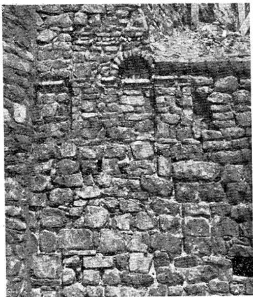
Сл. 13. Остаци ниша на југоисточној фасади цркве. — Fig. 13. Vestiges de niches sur la façade sud-est de l'église.
