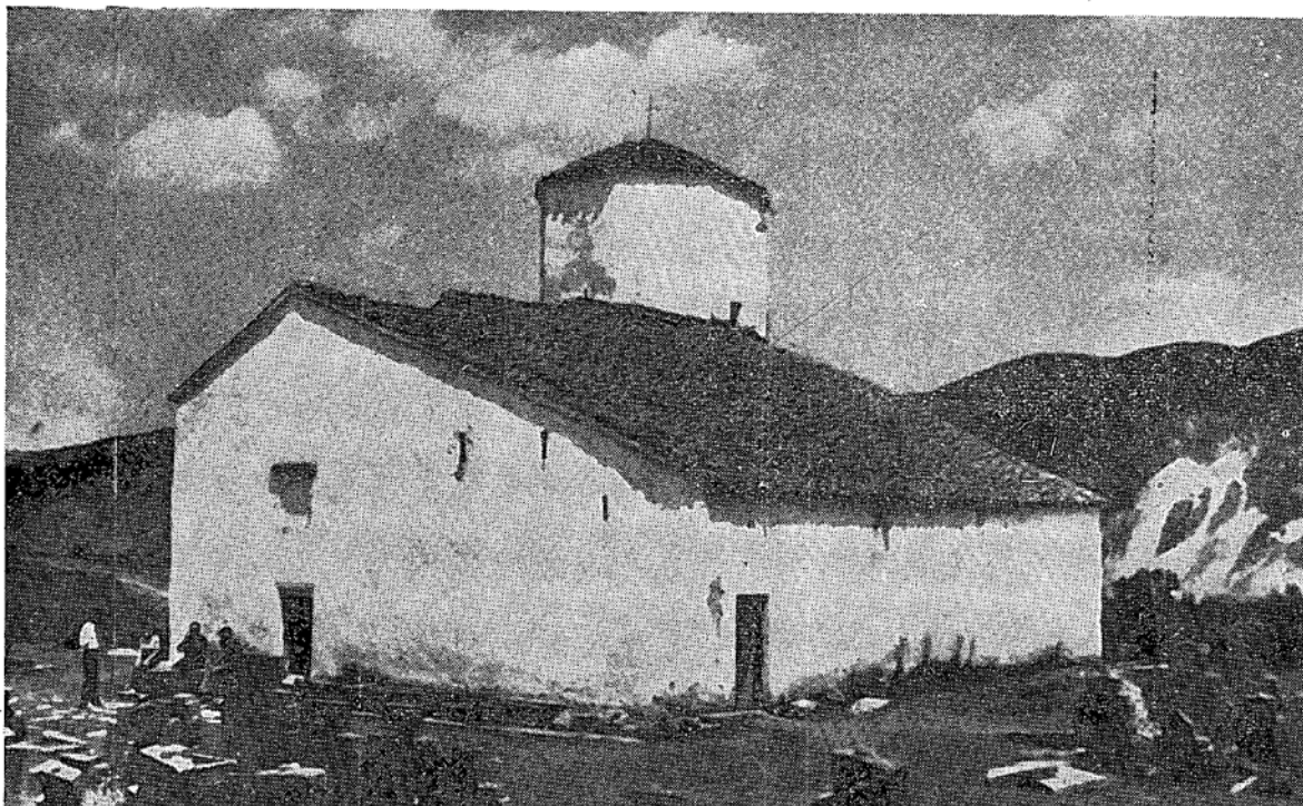
Сл. 4. Југозападни изглед пре конзервације. — Fig. 4. Face sud-ouest avant la conservation.
