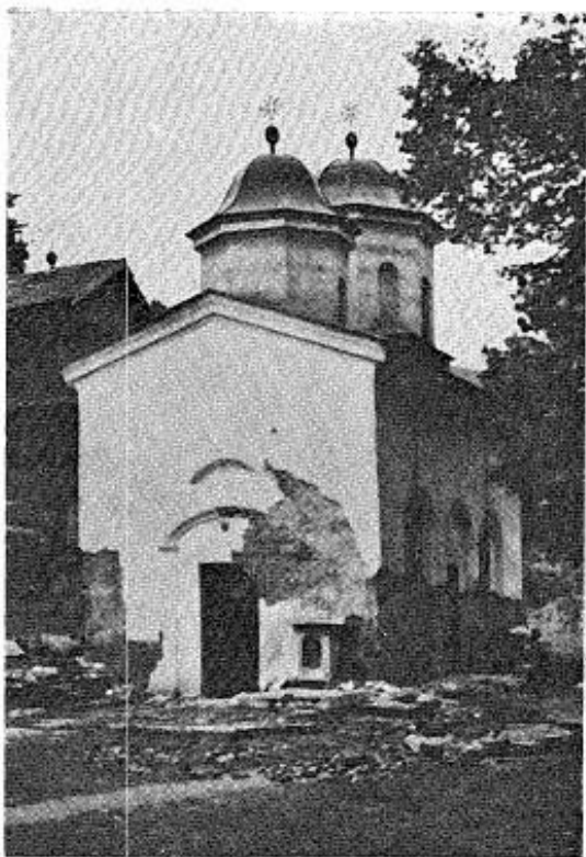
4. Jošanica, југозападни изглед цркве пре радова 1969. год. (фот. Р. Проклић) 4. Jošanica, aspect sud — ouest de l'église avant les travaux de l'année 1969. (photo de R. Prokić).
