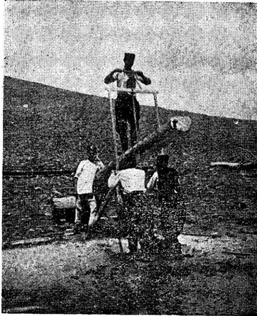
71. Златибор: Ручни струг за сечење балвана — »Zlatibor« : Scie de long débitant un bois en grume.
