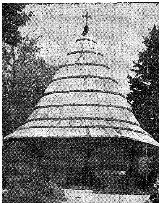
77. Рача Крагујевачка: Данашњи изглед цркве после извршених конзерваторско-рестаураторских радова — »Rača Kragujevačka«: Aspect actuel, après travaux de conservation et
