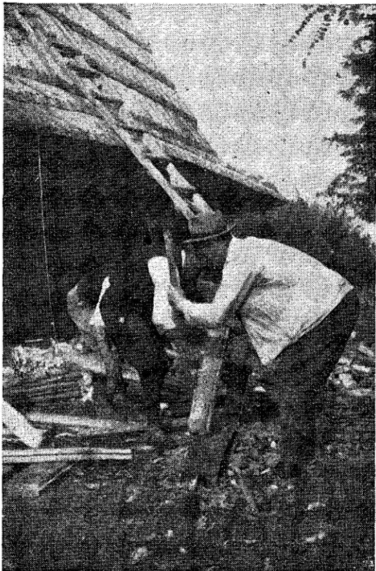
72. Брзан: Ручно притесавање шиндре — »Brzan«: Façonnement d'échandôles, à la hache.
