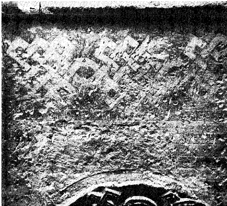
15. Љубостиња, новооткривени првобитни малтер са фасаде, са сликаним кордонским венцем (преплетом)
