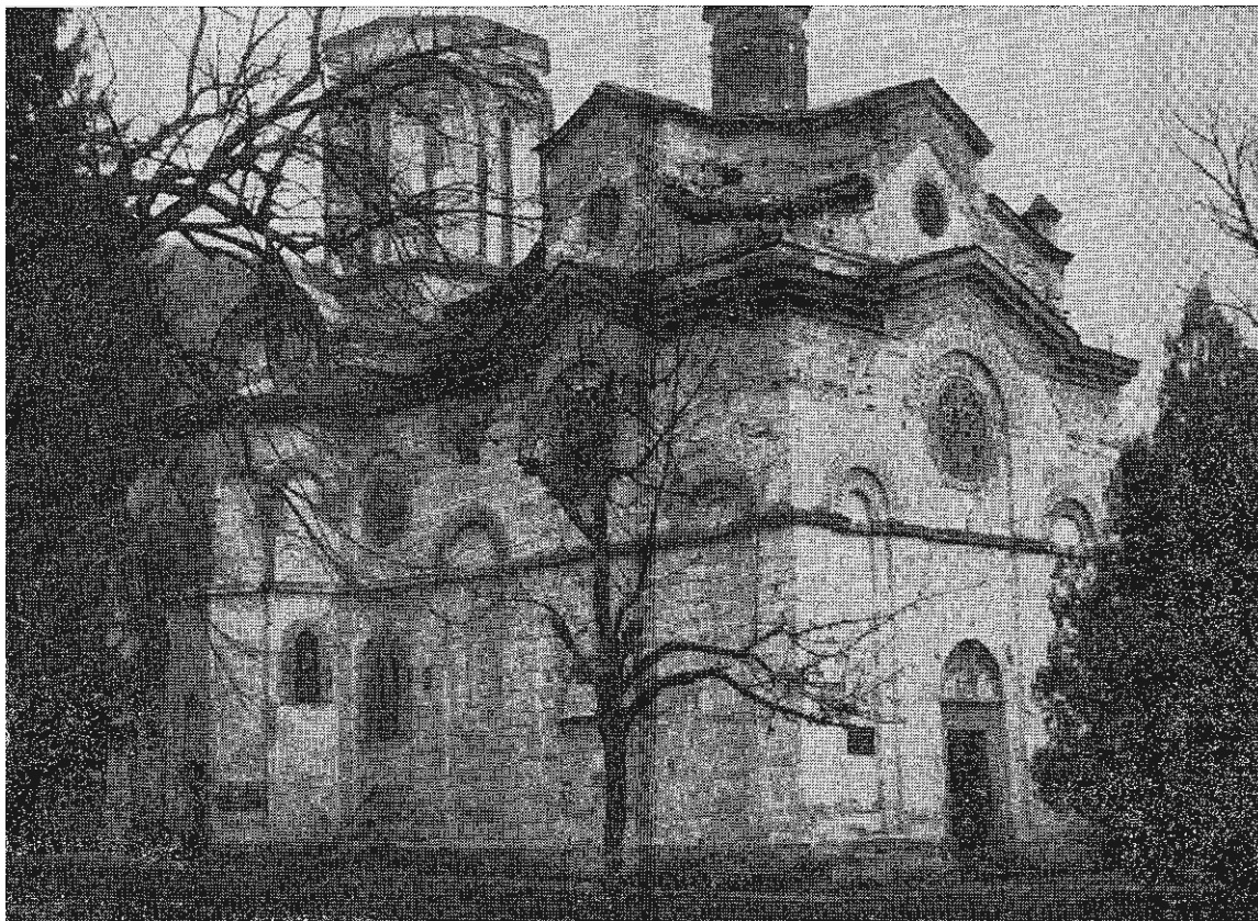
5. Љубостиња, фасада у току испитивања, после извршеног обијања познијих малтера (снимак И. Путића)
