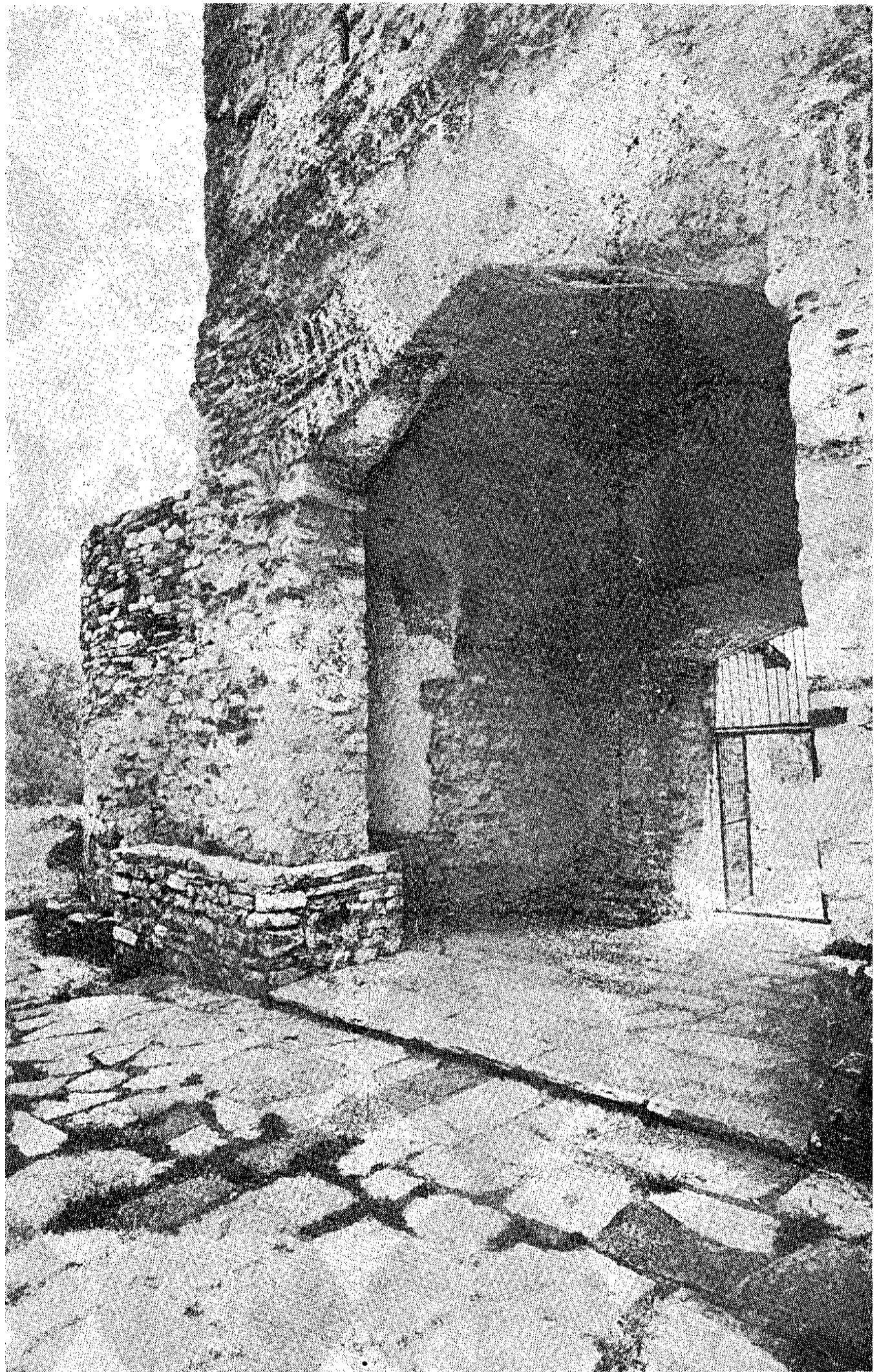
27. Изглед западног улаза после уклањања троугластих испуна и фуговања слободних површина, 1977. г. Р. Живковић.
