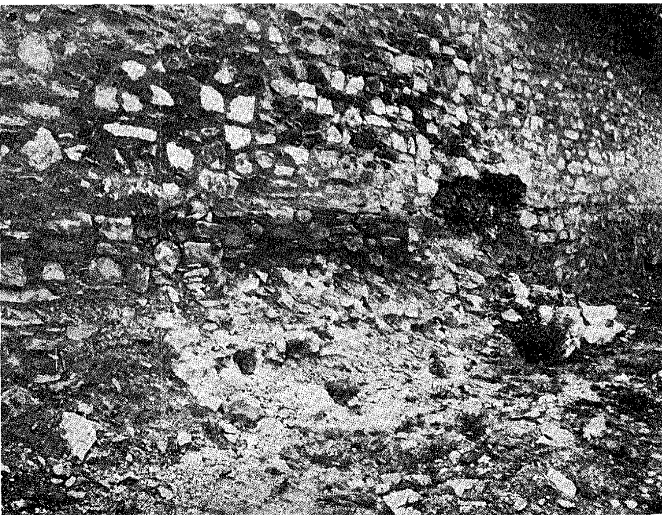
10. Приликом уклањања земље дуж зидова конака до трпезарије откривени су остаци једне троугласте куле, 1965. г. Р. Живковић.
