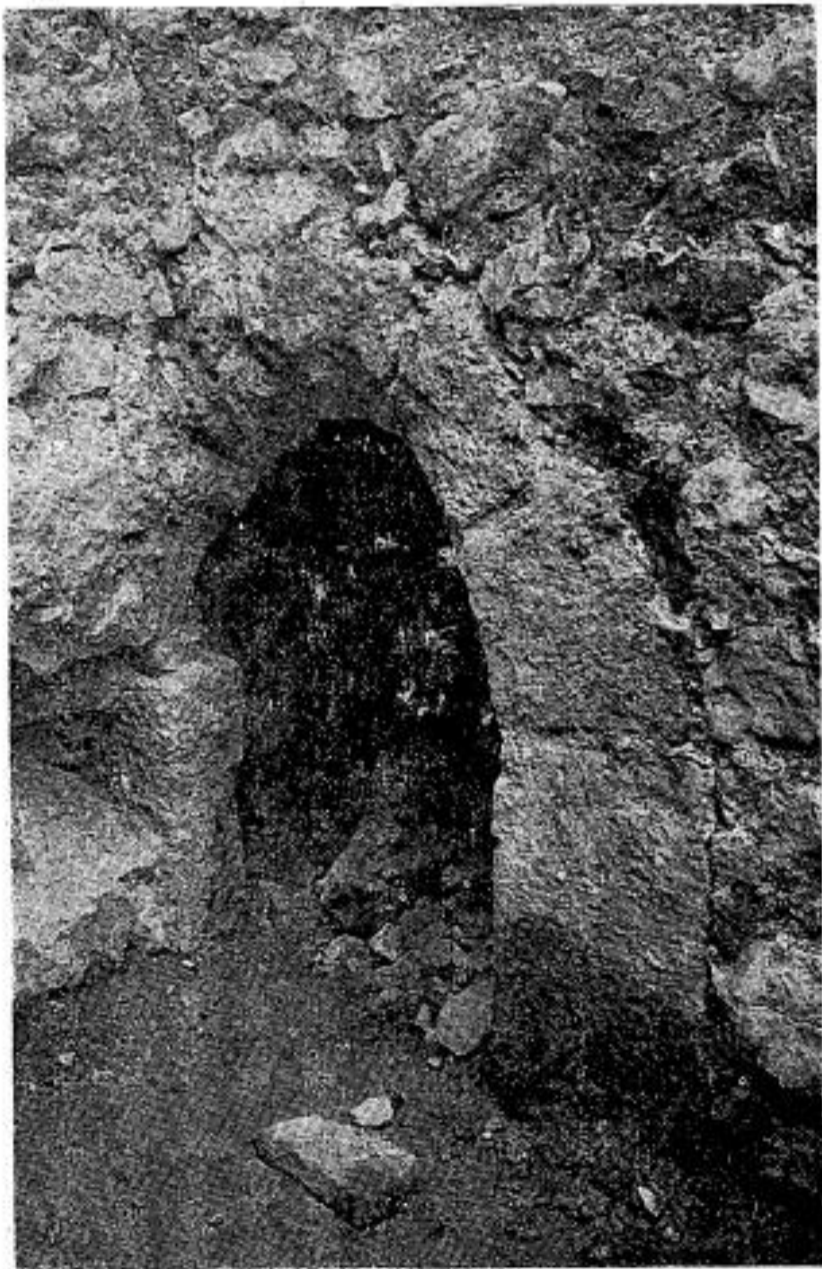
Сл. 10. Откривени улаз у кулу 6 Fig. 10. Entrée de la tour 6 (après déblaiement).
