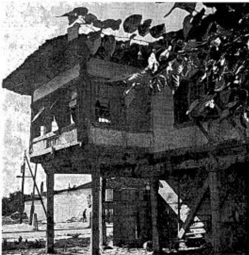
Сл. 27. Детаљ истурене „ћошке“ зграде. Виртуозитет конструкције и структуре.
