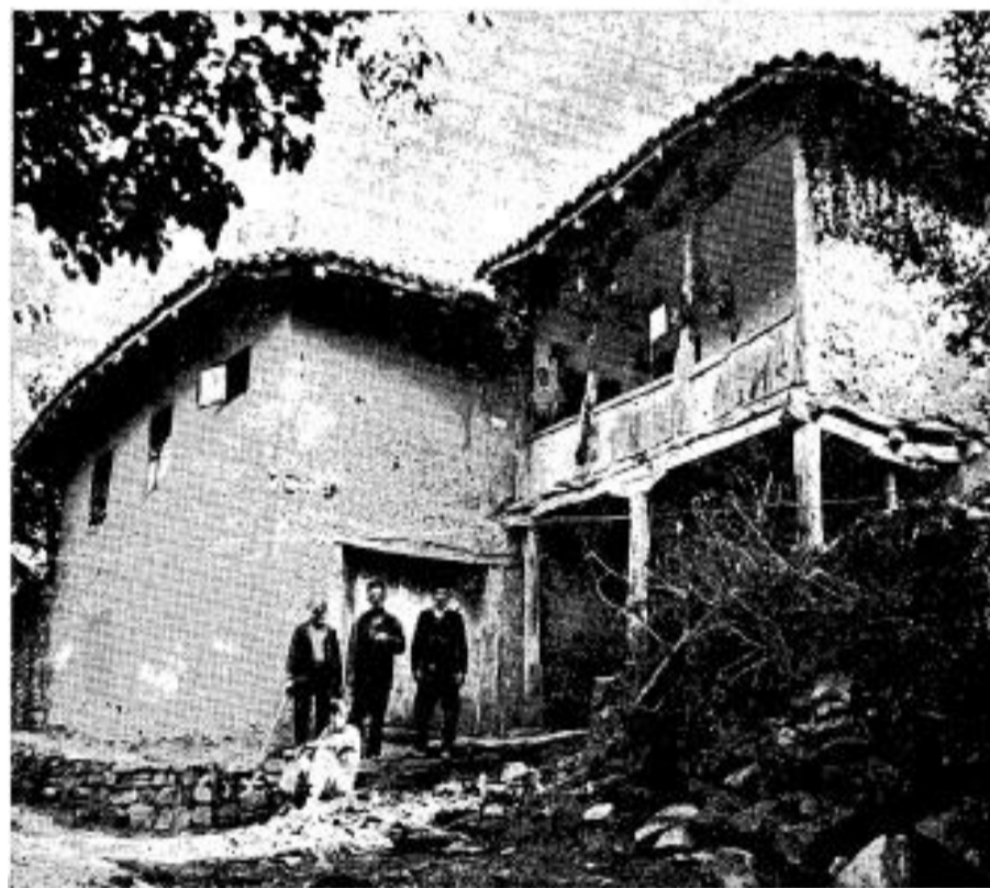
Сл. 14. Село Клашњице (Врање). Кућа на стрмом земљишту са тремом над подрумом
