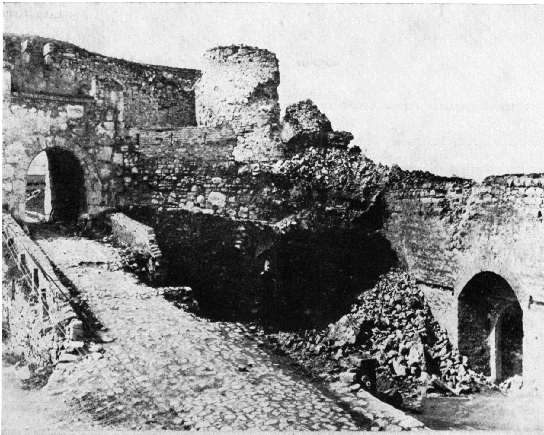
Сл. 1. Оштећења на Горњем граду Београдске тврђаве 1915. године (архив Музеја града Београда)
