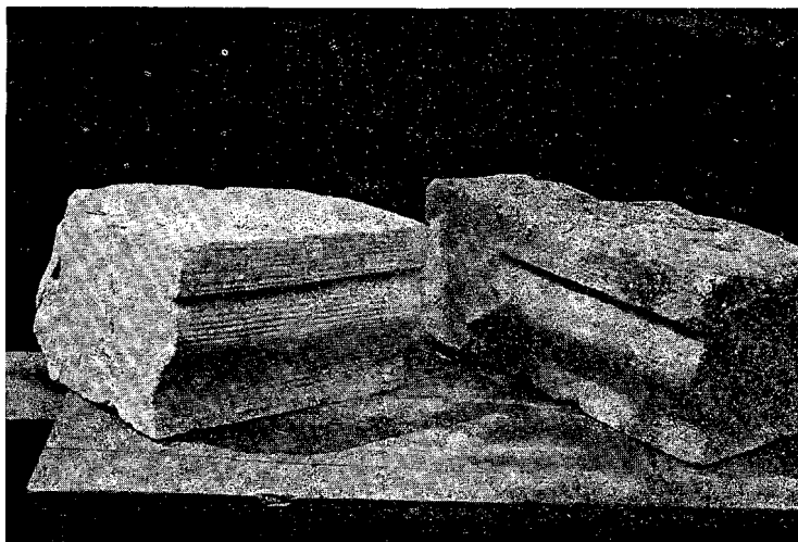
Сл. 18. Фрагменти оригиналног венца цркве са профилацијом за спој под правим углом (Снимак С. Мојсиловић-Поповић)
