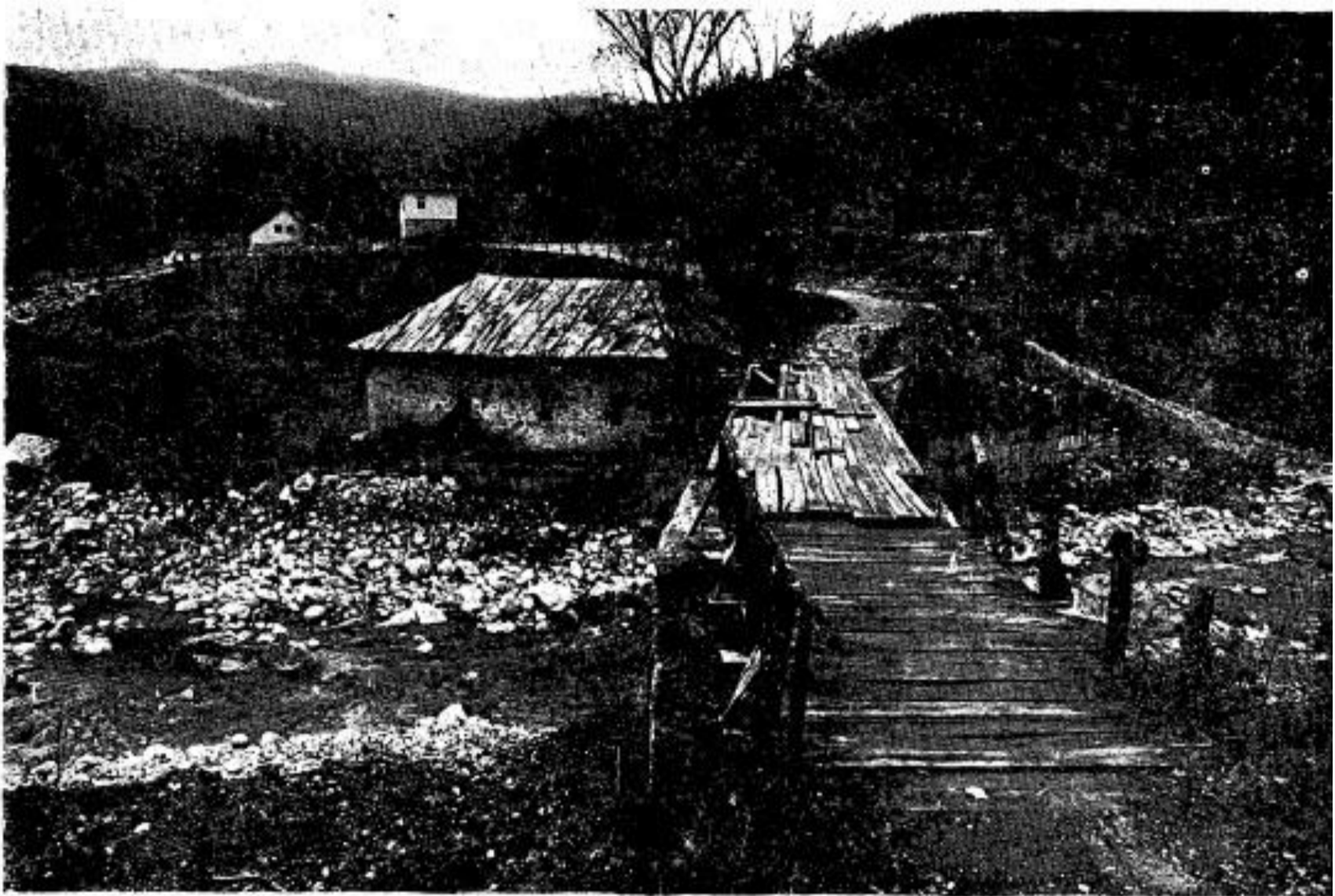
Сл. 4. Изглед воденице и моста са југозападне стране — садашње стање
