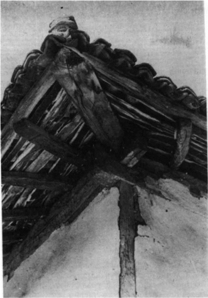
Сл. 11. Кућа Љубинковића, детаљ везе дрвене конструкције Fig. 11. La maison des Ljubinković, une jonction de la charpente, détail.
