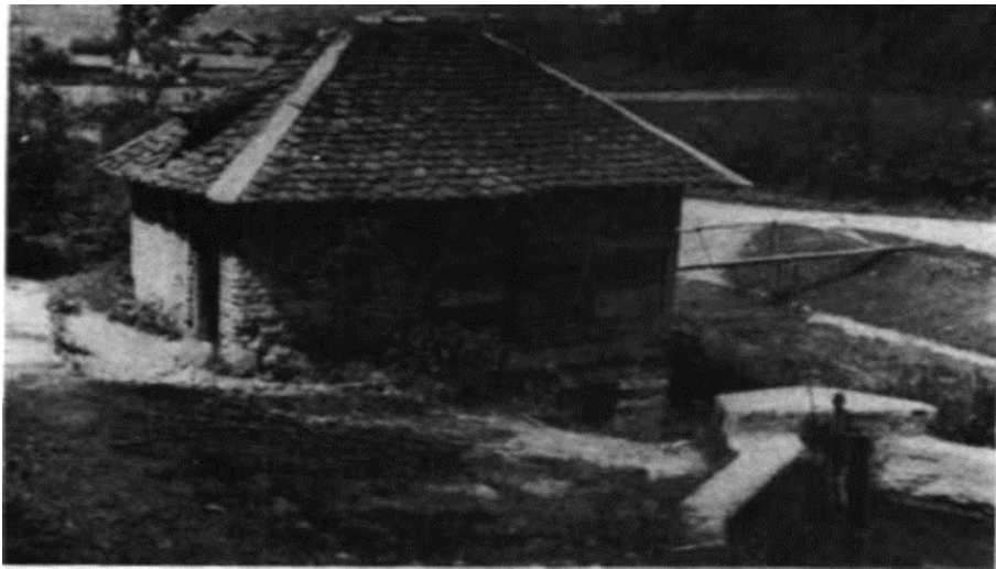
Сл. 27. Воденица у Белој Цркви код Крупња; воденица још ради, и добро је одржавана, ипак је морао бити замењен „бадањ“ новим који је изливен од бетона; и део јаза је бетониран.
