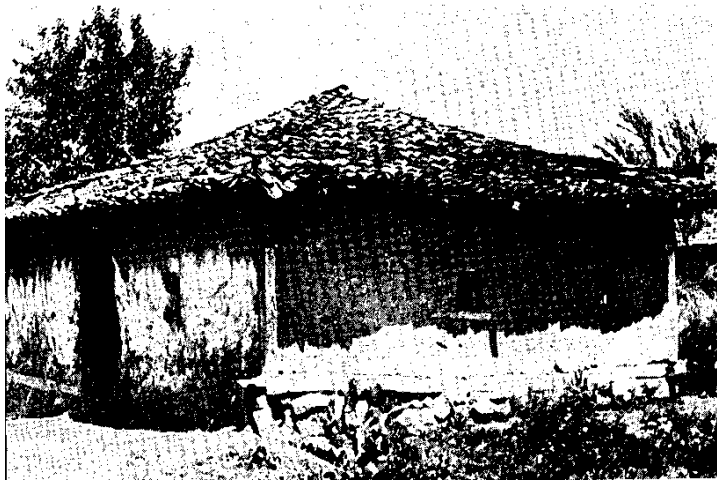
Сл. 7. Плетара са Косова. Овакве куће су градили сељаци чивчије. Првобитно је била покривена сламом. Fig. 7. Maison en torchis de Kosovo. Ces maisons étaient construites par les čivčiје (métayers). Elle était à l'origine couverte de chaume
