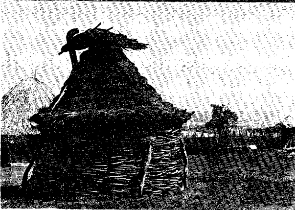
Сл. 8. Колибе са пећинског Коштан Поља. Зид од плетера без носећих стубова, лежи на гредама темељачама. Изнутра је облепљен блатом. На доњој слици „бусак“ средишњи простор стана у коме је само ватра. Спава се по колибама у којима се ватра не ложи. Fig. 8. Cabane de Koštan, Polje sur le haut-plateau de Pestern. Le mur est en torchis sans poutres de soutien, élevée sur des assises en grosses poutres. A l'intérieur elle est crépie en argile. Au bas on voit le «busak» (foyer) au centre de la maison où l'on entretenait le feu. On dormait dans des cabanes sans chauffage
