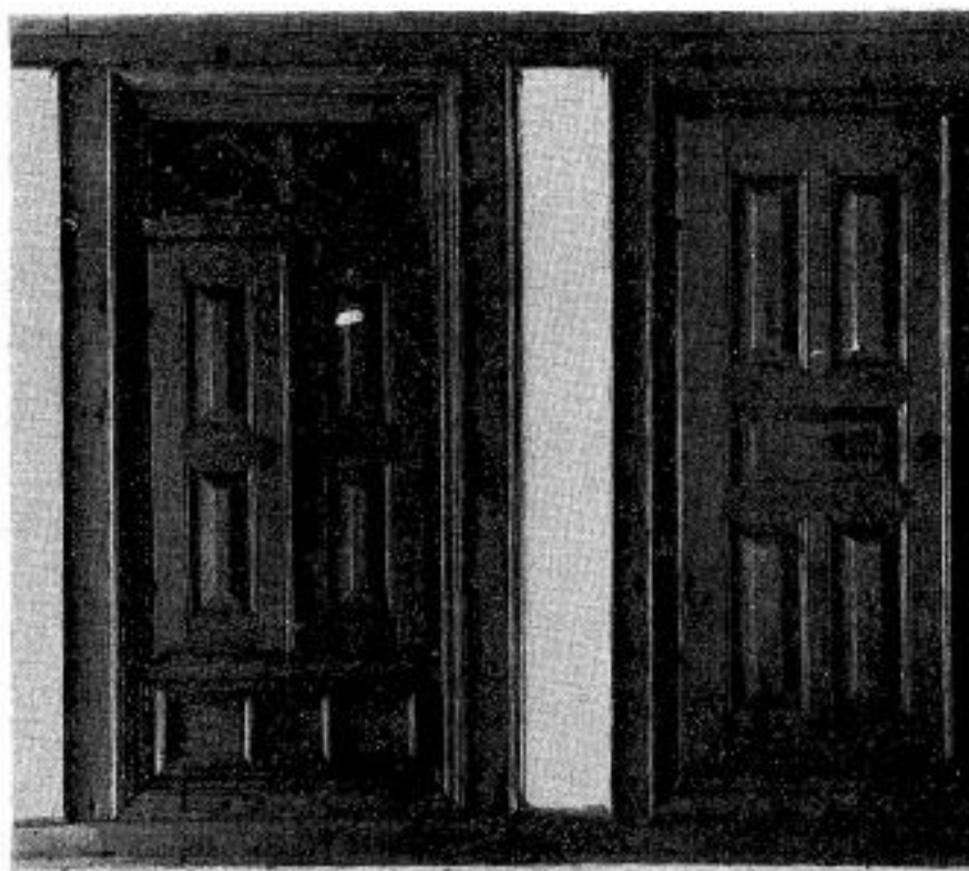
Сл. 20. Зидови по собама врло су често издељени оквирима, којима се покривају спојеви дрвеног костура и зида од ћерпића или цигле. На фотографији су приказана два узидана плакара „долана“ који су уклопљени у дрвене оквире зидне облоге.
