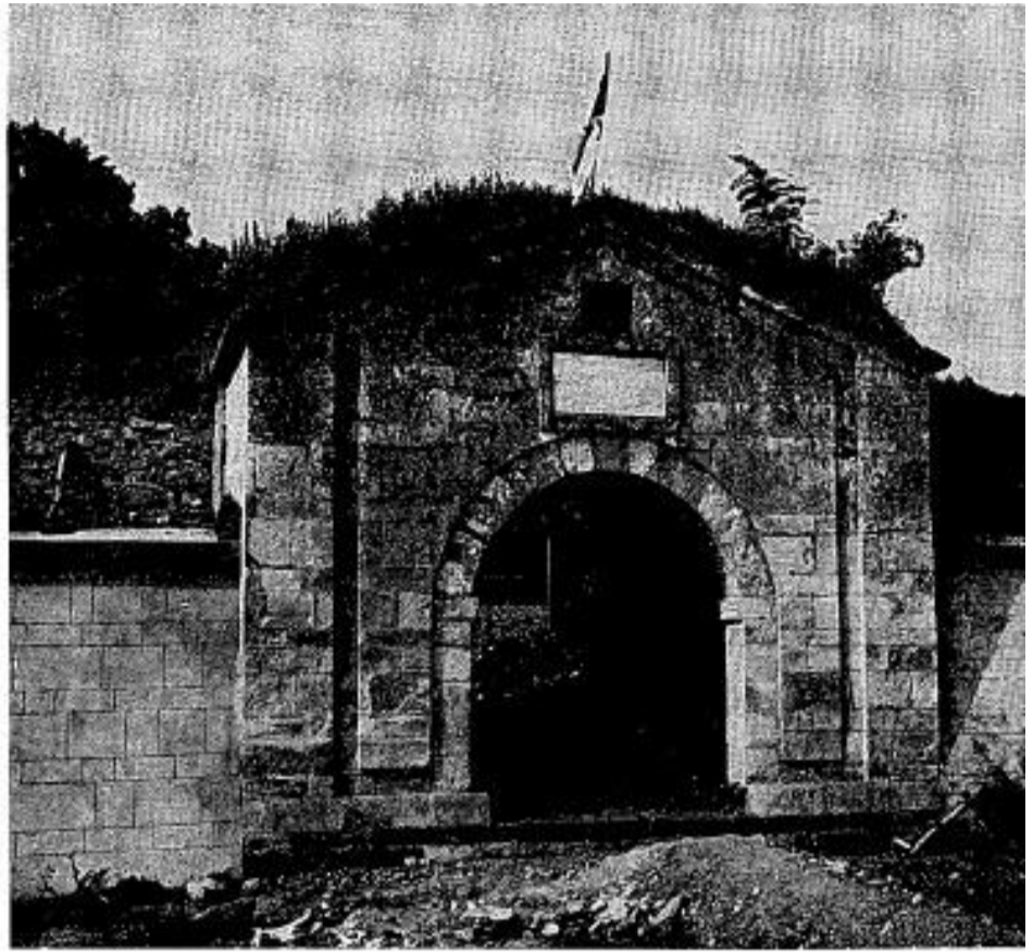
Сл. 19. Изглед Дунавске капије после изведених конзерваторско-рестаураторских радова (снимио Н. Живковић) Fig. 19. La Porte du Danube après l'achèvement des travaux de conservation et de restauration (Photo N. Živković)
