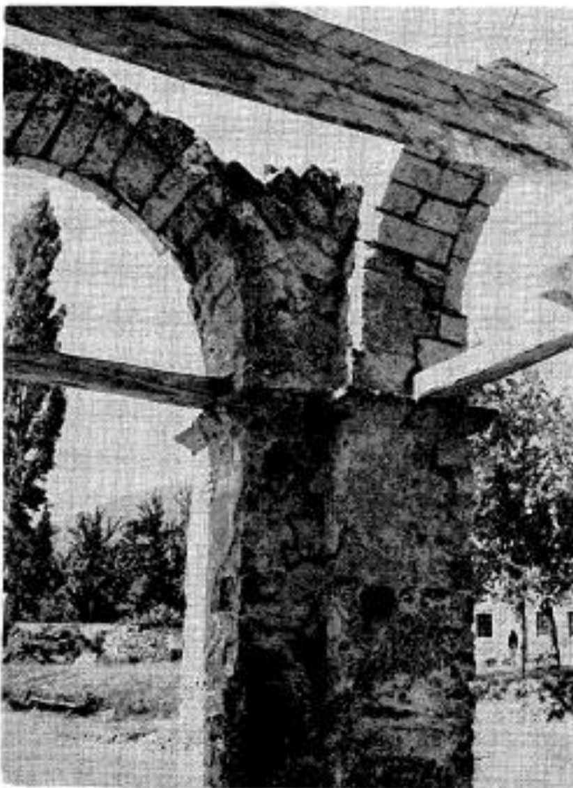
Сл. 4. Остатак кугластог свода у припрати Fig. 4. Vestiges de la voûte en plein cintre du narthex
