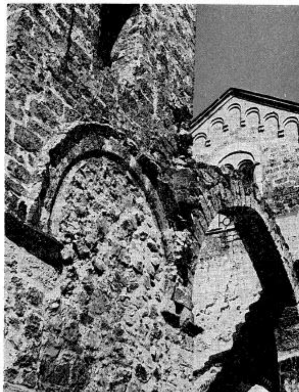
Сл. 15. Остаци пиластра западног зида спољне припрате, сачувани уз јужни зид звоника (пре конзервације) Fig. 15. Vestiges du pilastre du mur occidental de l'exonarthex, subsistant contre le mur méridional du clocher (avant la restauration)
