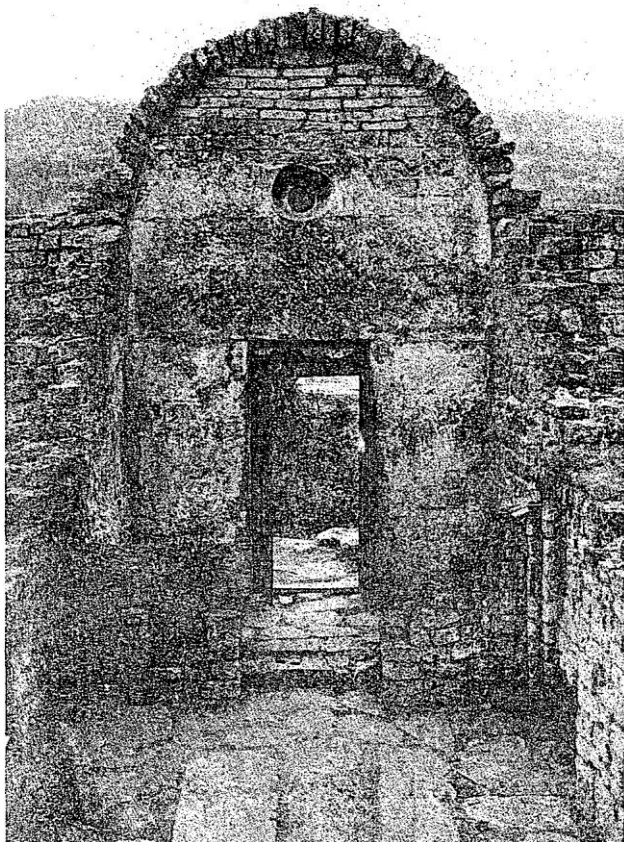
Сл. 2 Унутрашњост цркве, с изгледом западног зида, пре обнове (фото В. Мако)
