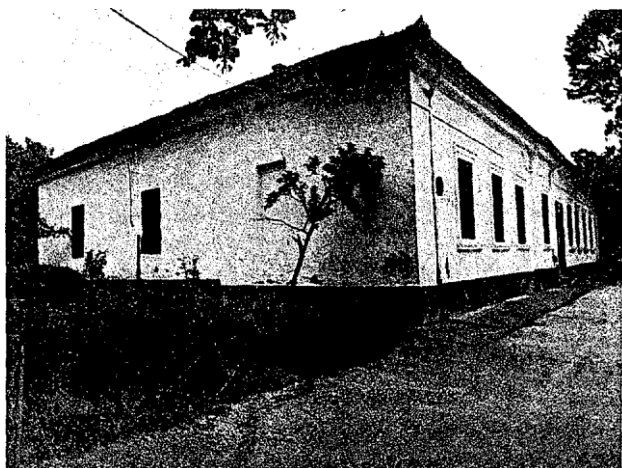
Сл. 8 Зграда школе, подигнута 1857. Године
