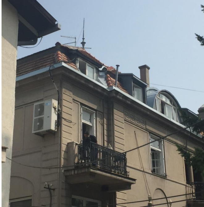
јужни изглед зграде
