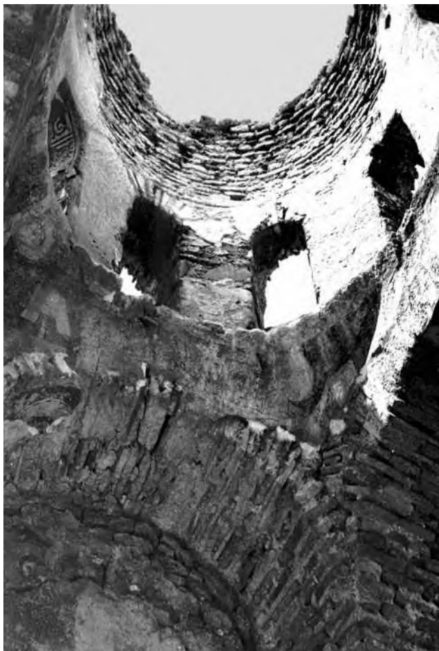
7. Остатак првобитне куполе изграђене од танких квадера сиге 7. Remains of the original dome made of thin tufa cuboids
