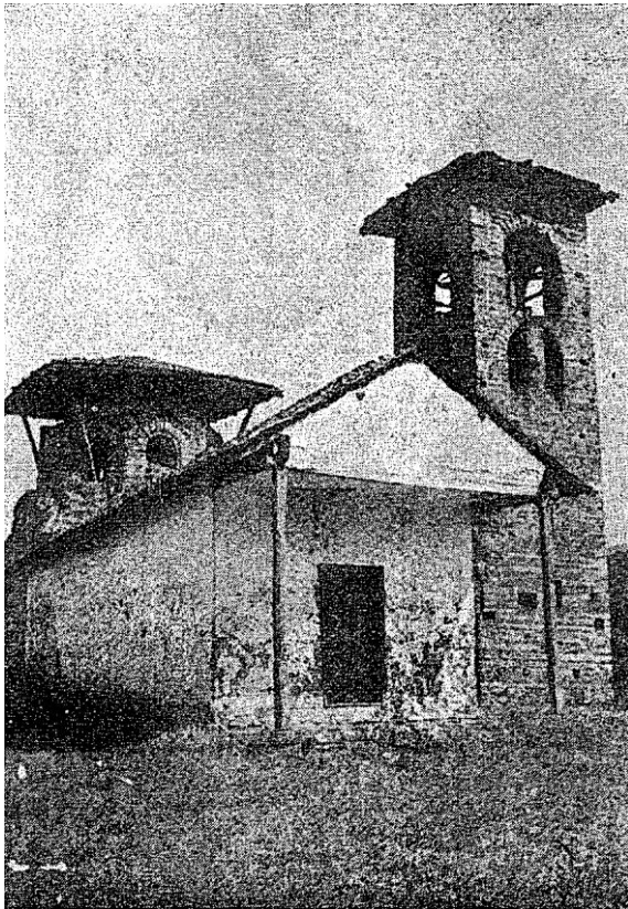
Сл. 1. — Изглед цркве св. Николе пре конзервације
