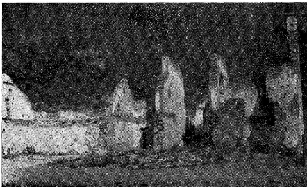
Сл. 1. Рушевине болнице 1951. године. — Fig. 1. Ruines de l'hôpital en 1951.
