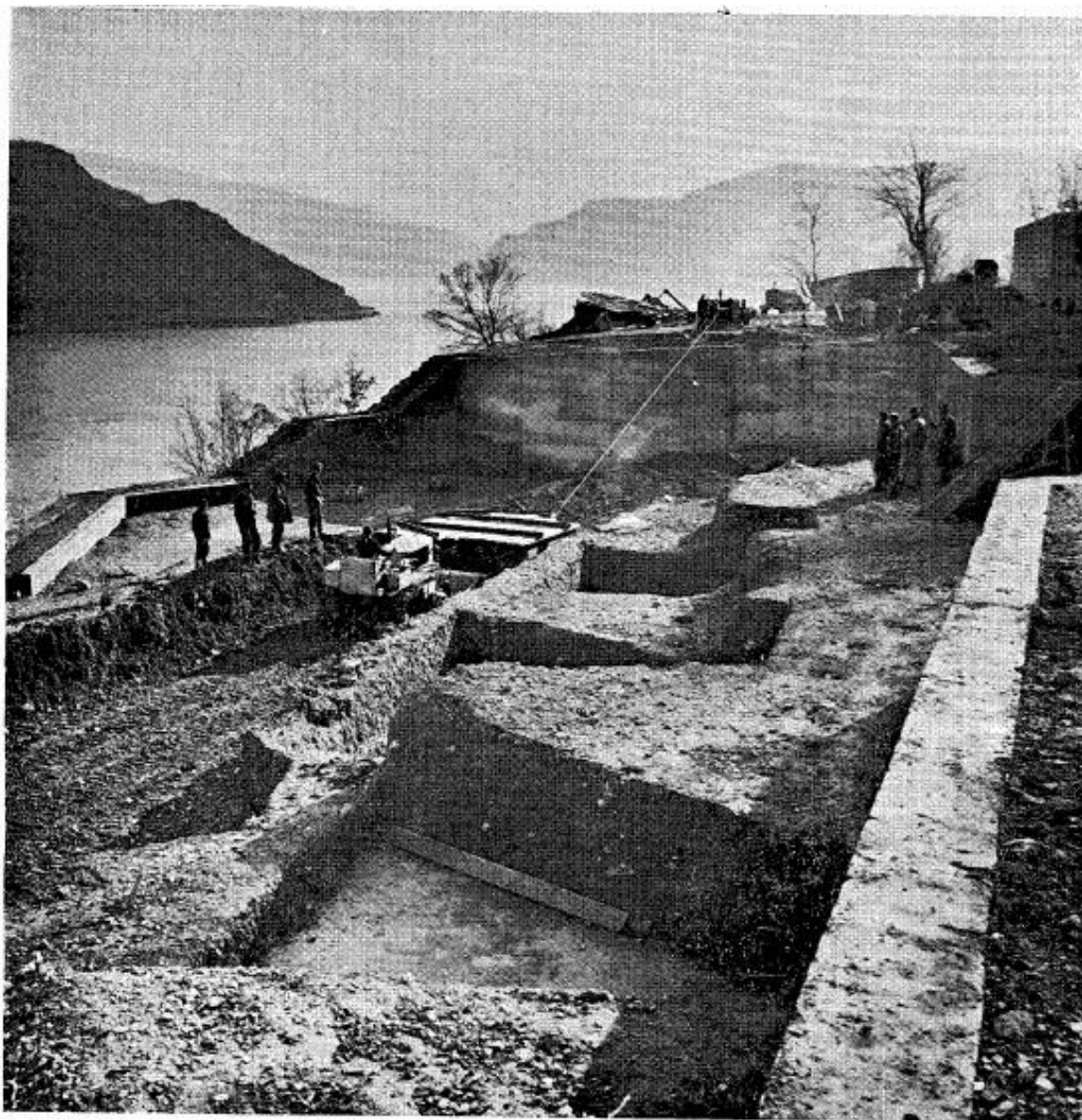
20. Горњи плато са припремљеним бетонским постољима за објекте који се преносе у целини — снимак М. Медић
