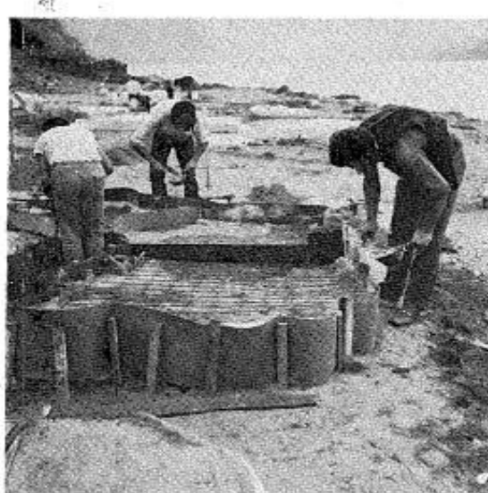
11. Заливање полеђине пода — снимак М. Медић 11. Arrosage de l'envers du plancher, photo M. Medić
