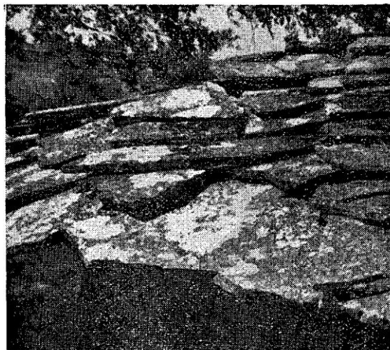
37. Гораждевац: Кровни покривач од камених плоча — »Goraždevac«: Toiture dallée.
