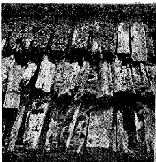
36. Рача Крагујевачка: Кровни покривач од крупне шиндре — »Rača Kragujevačka«: Toiture en grosses échandoles.
