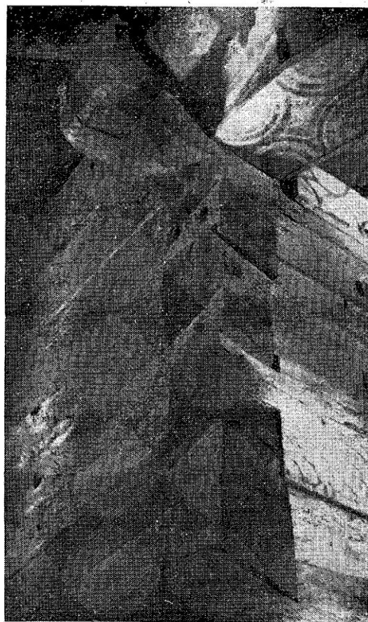
32. Покајница: Угаона веза »на ластин реп« без препуста — »Pokajnica«: Emboîtement angulaire en »pennes d'hirondelle«, sans saillies.
