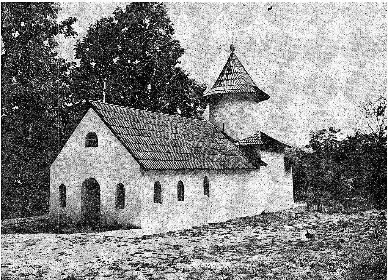
6. Јовања, код Ваљева, изглед цркве по завршетку радова
