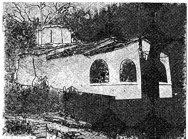
5. Изглед цркве пре почетка конзерваторско-рестаураторских радова.
