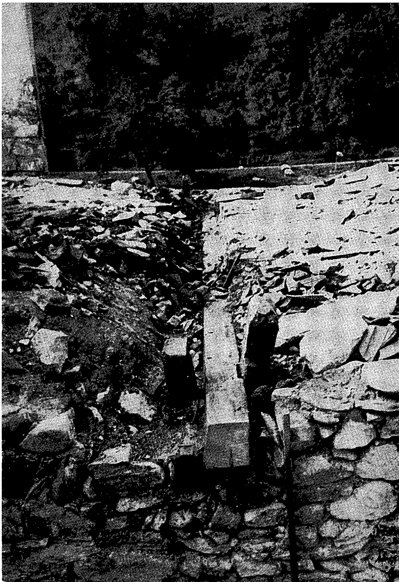
114. Милошев конак — косе греде биле су на крајевима прихваћене хоризонталним гредама које су биле и ослонци за крстасте сводове, Р. Живковић.
