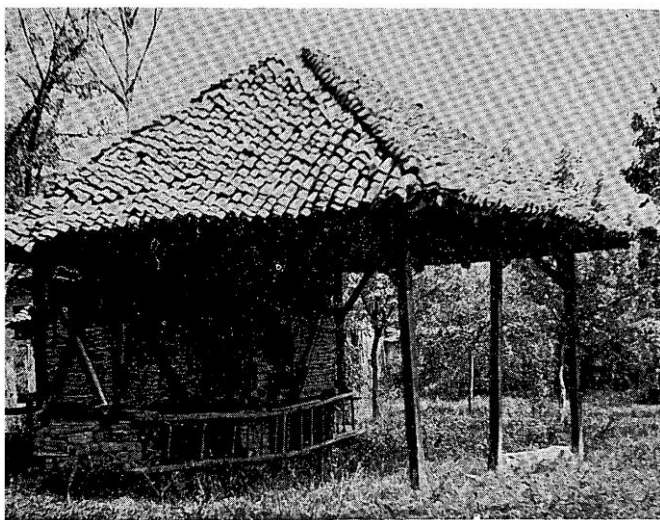
Сл. 23. Спанце (Куришумлија), кош за кукуруз, оплетен прућем, ојачан дрвеном конструкцијом, са тремом „ајатом” и стубовима који носе кров
