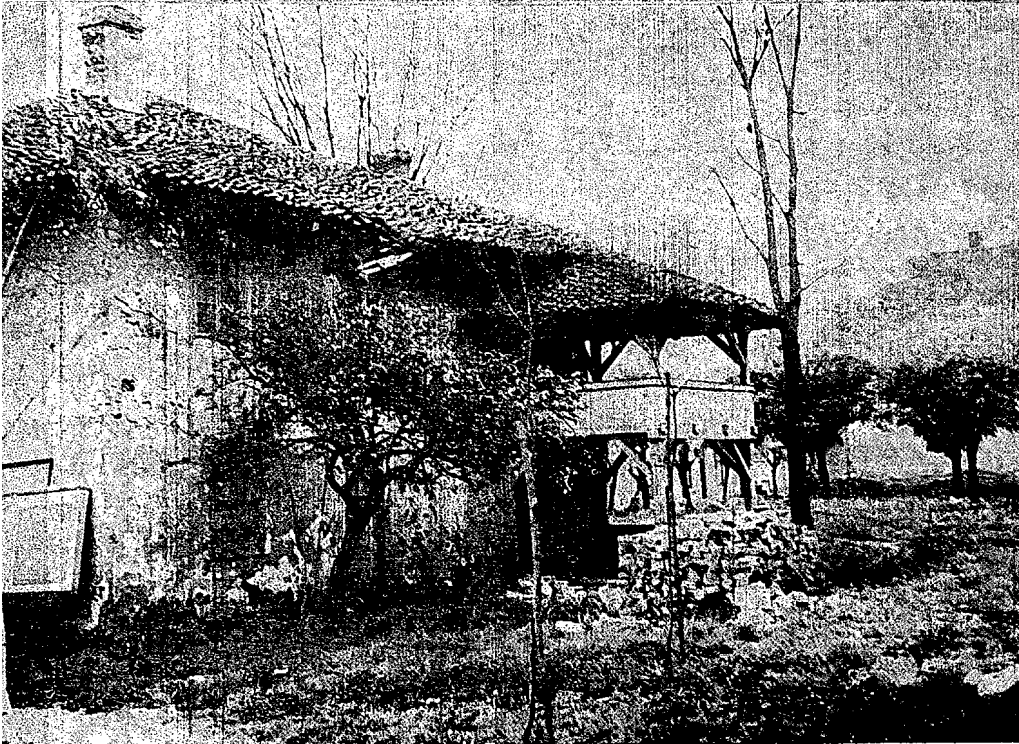
Сл. 7. Симићева кућа у Крушевцу, изглед уличне фасаде пре конзервације
