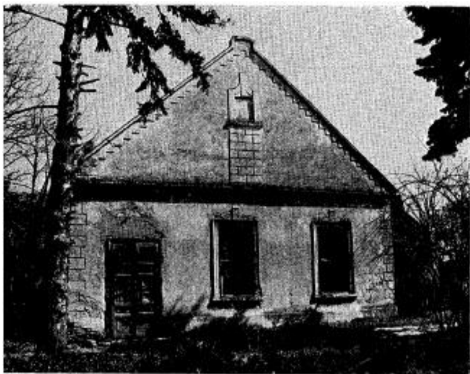
Сл. 2. Улаз у дограђени део објекта Fig. 2. Entrée de l'annexe
