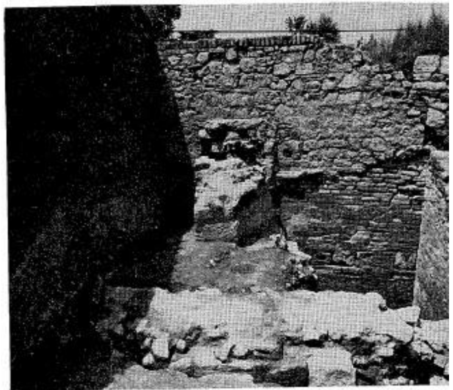
Сл. 10. Приобални бедем у Доњем граду, простор уз кулу Небојшу — унутрашња страна куртине са контрафором из млађе фазе (фото Н. Борић)
