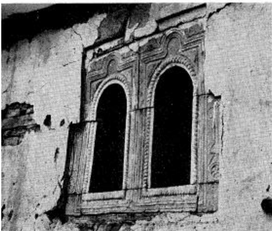
Сл. 9. Двојни прозор на спрату шиптарске куће у селу (снимак 1966. г.) Fig. 9. Fenêtre bilobée à l'étage d'une maison skipétare dans le village de Petchani (photo de 1966)
