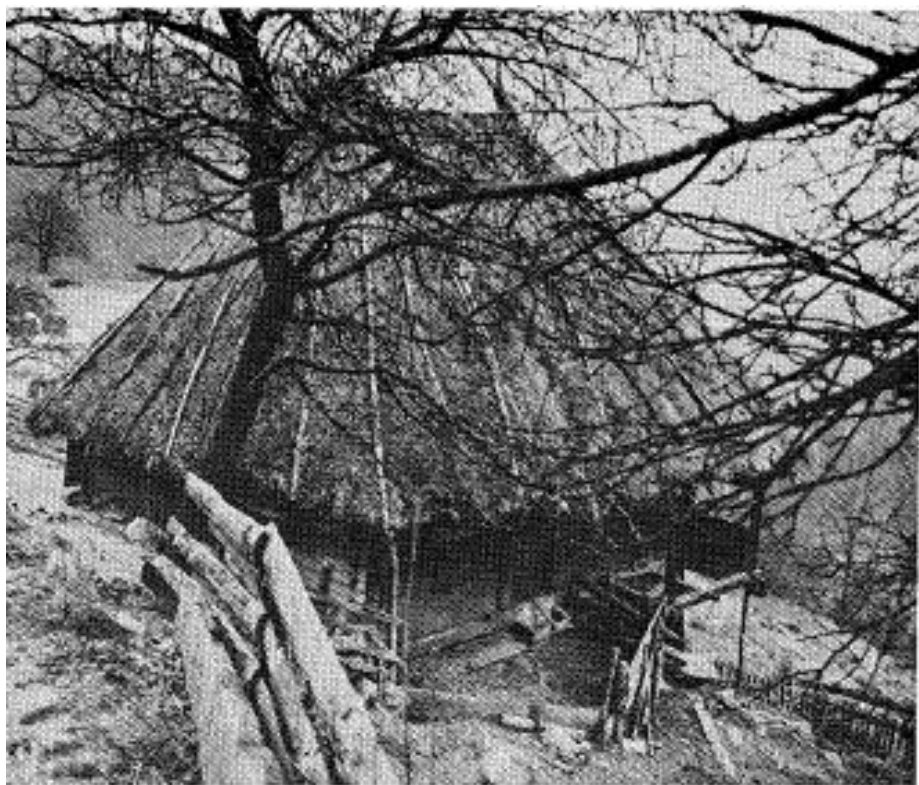
Сл. 50. Бајале, кућа Радојка Бајалца Fig. 50. Bažale, maison de Radojko Bažalac
