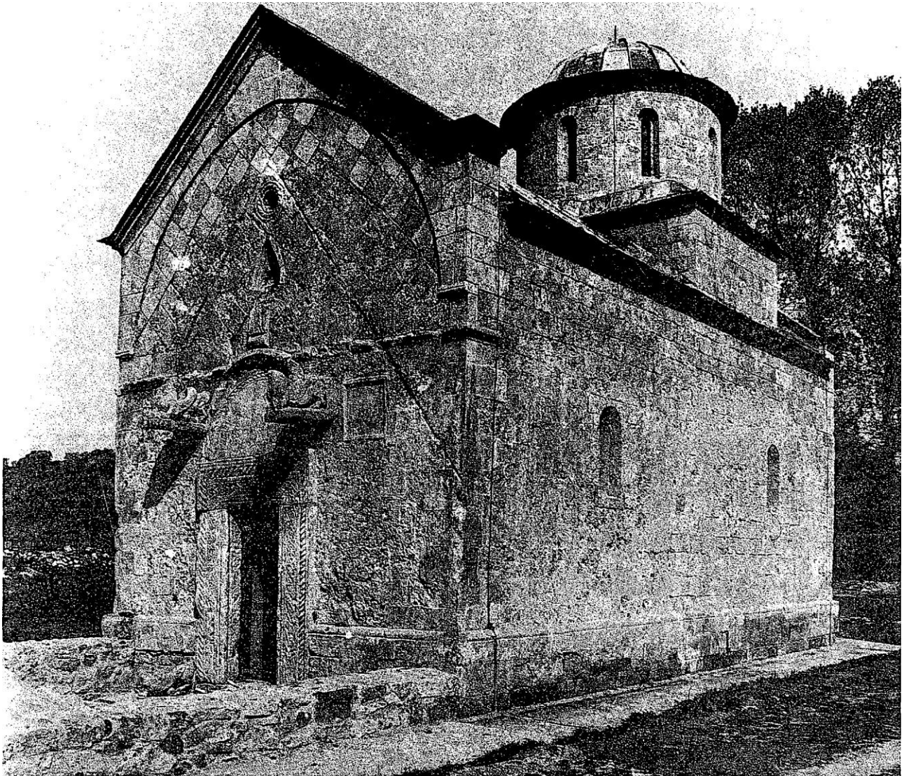
Сл. 2 Поглед на западну фасаду цркве на којој се виде жлебови од ранијих дрвених тремова
