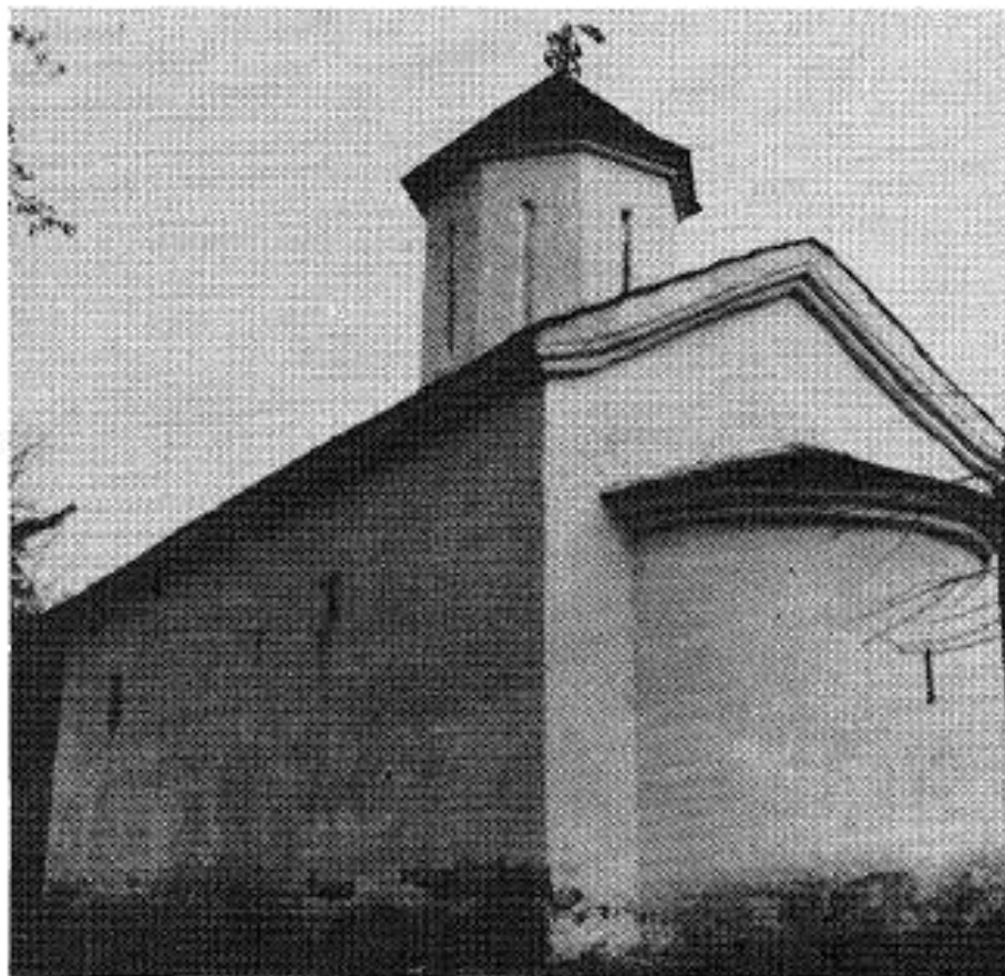
Сл. 6. Југоисточни изглед цркве
